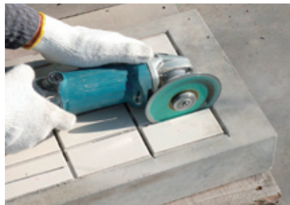
写真-4 はつり時の深さに合わせて目地部に切り込みを入れる
