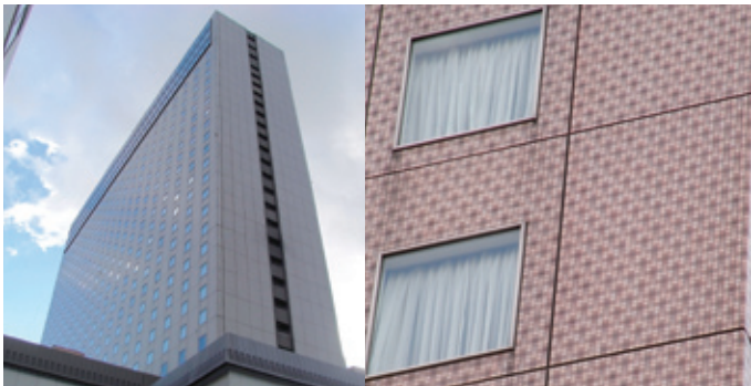
写真-1 大阪ロイヤルホテル（1971年） 45×45mmのタイルを打ち込んだ初期の例、40年近く経過した現在も健全な状態が維持されている
