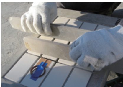
写真-12 治具を使用し周辺タイルとの面、目地通りなどを合わせる
