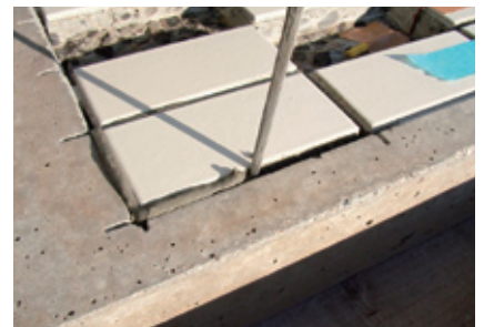
写真-11 タイルを圧着し、目地部からはみ出る余分なモルタルは除去する
