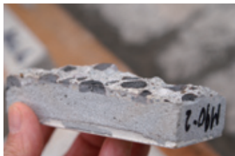
写真-17 モルタルと下地コンクリート界面付近で破断
