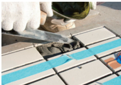
写真-9 下地コンクリート面に貼付けモルタルを塗布する
