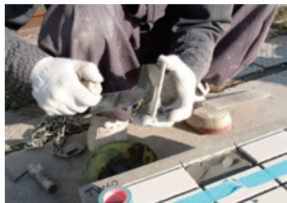
写真-10 タイル裏面にも貼付けモルタルを塗布する
