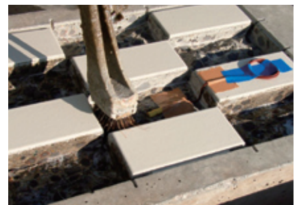
写真-8 下地コンクリート面に吸水調整剤を塗布する
