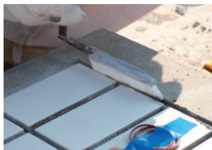
写真-13 目地詰め用モルタルを目地に充填して仕上げて、清掃後完了
