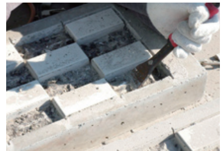
写真-5 コンクリートを所要の深さまでのはつり
