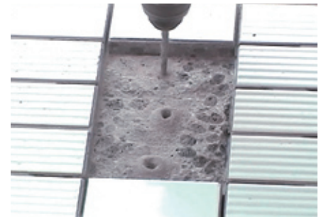
②：貼替えタイルのはつり後にアンカー用の穴空けを行う
