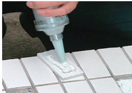
⑬：貼替えタイルの裏面に接着材を塗布し、下地側へ貼り合わせる
