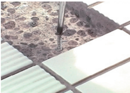
⑤：ねじを出寸法 3mm 残して取り付ける
