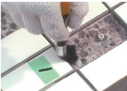
⑥：下地コンクリート面に吸水調整材を塗布する
