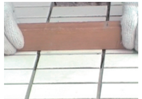
⑨：貼替えタイルを押し付け、定規を当てて周辺タイルと面一になるまで入念に叩き押さえを行う
