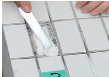
⑫：コンクリートはつり部分に接着剤を充填している状況
