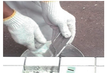
⑧：貼替えタイルの裏面に貼付けモルタルを塗布する
